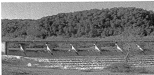
Φράγμα (φωτ. Δ. Ζαραβέλα)
